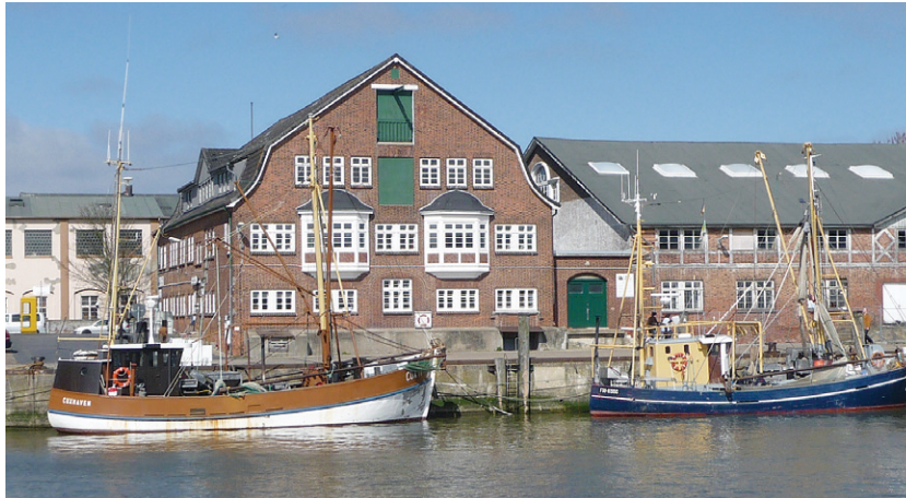
Das einstige Reedereigebäude der „Nordsee“ am Alten Fischereihafen in Cuxhaven an der Kapitän-Alexander-Straße im Jahr 2010 (Foto: Dr. Dirk J. Peters)
