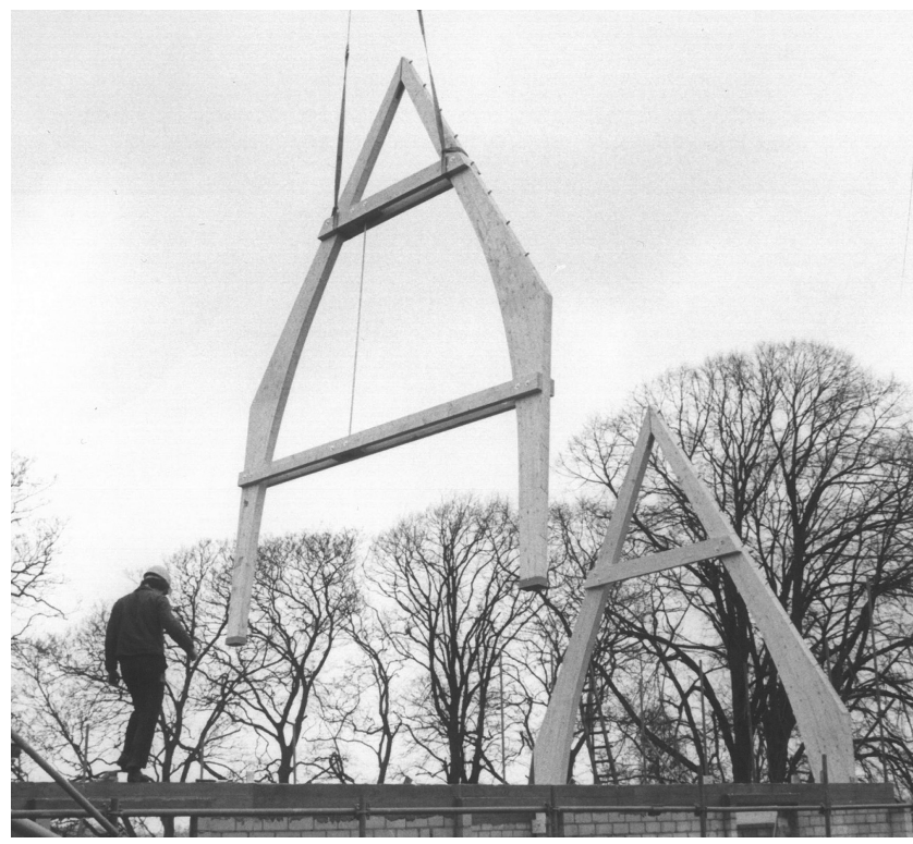
Beim Wiederaufbau des Nordflügels wurden die Dachträger des „hohen Saals“ vorgefertigt mit einem Kran an ihren Platz gehoben. (Foto: Archiv Burg Bederkesa)
