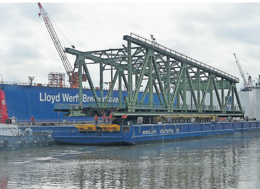
Abtransport des langen Teils der Drehbrücke am 10. April 2021. (Foto: Dr. Dirk J. Peters)
