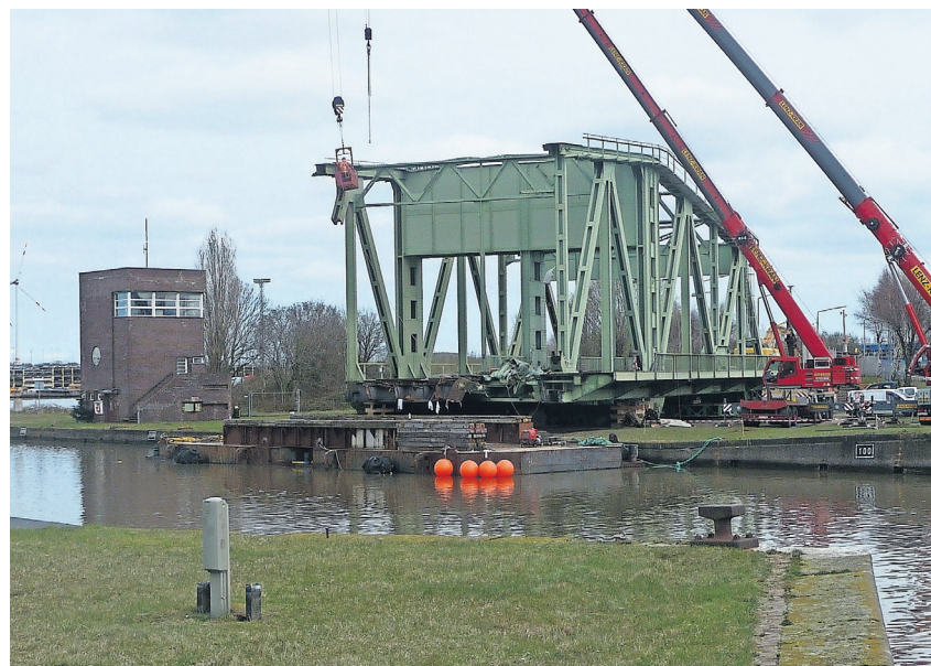
Brückenteil mit dem Drehkranz und dem Maschinenhaus an der Brückenstraße, 10. April 2021. (Foto: Dr. Dirk J. Peters)
