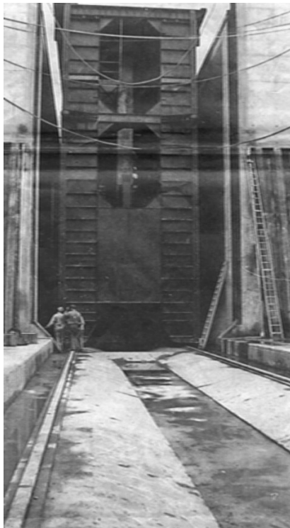
Bau der neuen Schleuse in der ersten Hälfte der 1960er Jahre. (Abb.: Sammlung Bussler)
