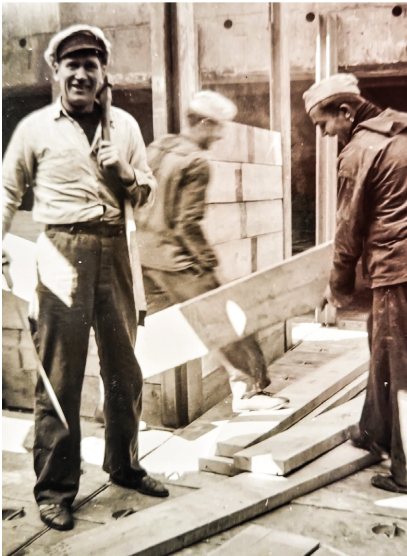
Feederbau auf der NABOB für den Getreidetransport
