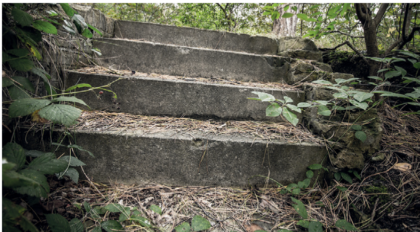
Die Treppenstufen vom Beobachtungsstand BERTA
