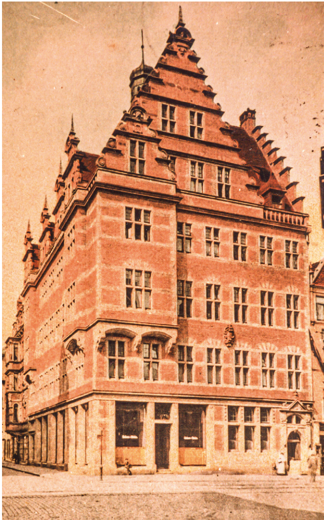
Das Gebäude der Sparkasse war aufwändig gestaltet. Mit seiner Gliederung, den Giebeln und der Fassadengestaltung war es eine deutliche Reminiszenz an die Architektur der Stadt Bremen und entsprach gleichzeitig dem wilhelminischen Zeitgeist
