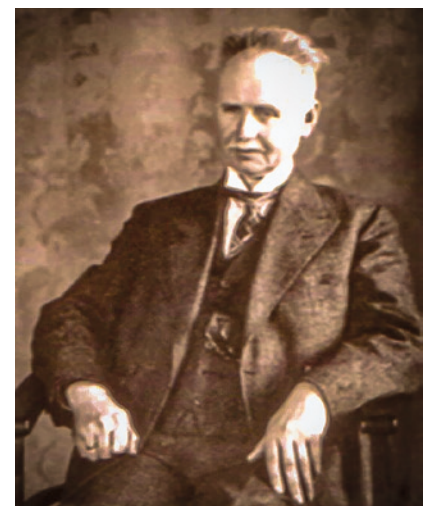
Bürgermeister Bleick Max Bleicken absolvierte 1913 die Probefahrt auf der Straßenbahn in Cuxhaven
