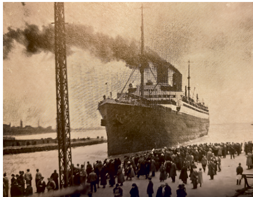
Der COLUMBUS des NDL bei der Einfahrt in die Kaiserschleuse
