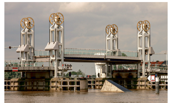
Hubbrücke mit goldenen Rädern auf den Eckpfeilern der Hebekonstruktion über die IJssel in Kampen
