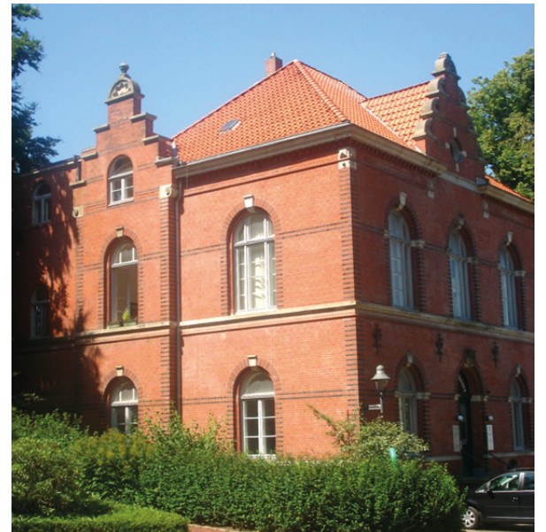
Das 1892 errichtete Amtsgerichtsgebäude und Katasteramt im Schlossgarten
