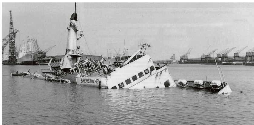
Die BREMERHAVEN liegt nach der ersten Phase der Bergung nicht mehr an der Kaje, aber tief im Wasser. (Abb.: Nordseezeitung)
