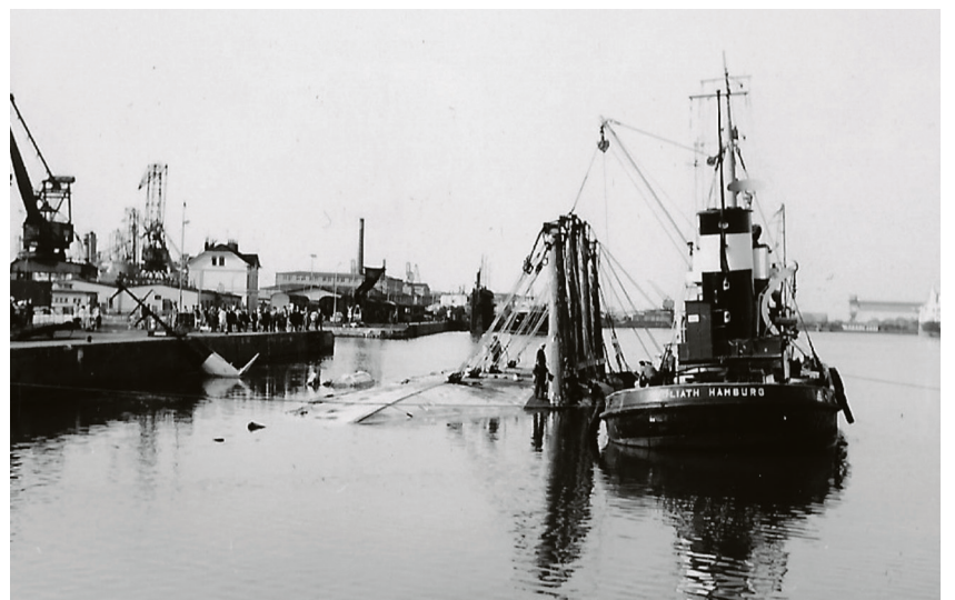
Der Bergungsschlepper GOLIATH liegt mit der Backbordseite an den vier Böcken. An deren Spitzen sind die Zugseile der Bergungsschiffe befestigt.
