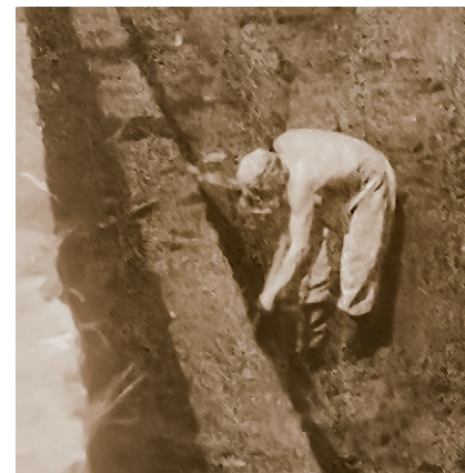
Strafgefangene beim Ausheben der Gräben (Abbildung aus Ahrendt, S. 57)
