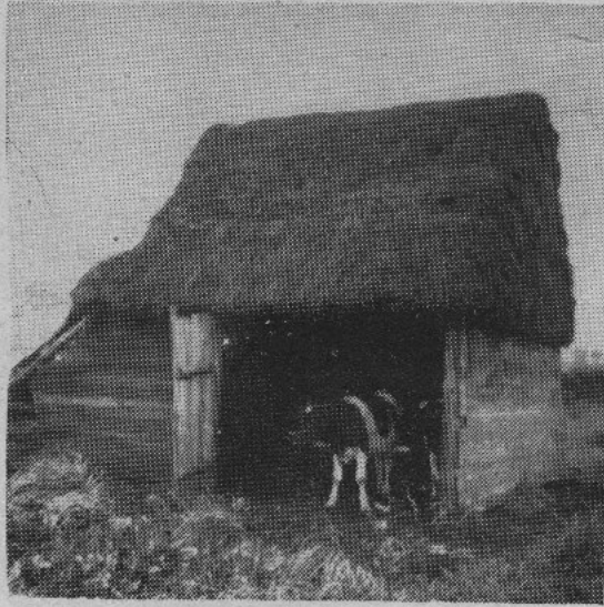
Schutzhütte unter Heideplaggen.
