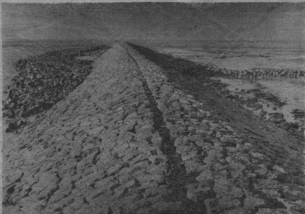
Steinbühne im Watt bei Solthörn, angelegt im Herbst 1949, über 500 Meter lang
