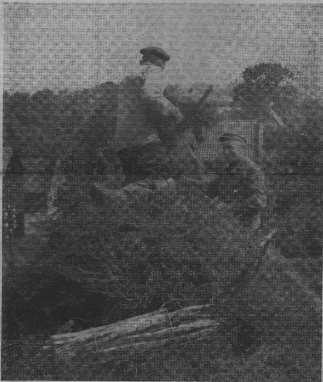
Hoch auf dem First des alten Niedersachsenhauses wird die „Heidiast“ erneuert
