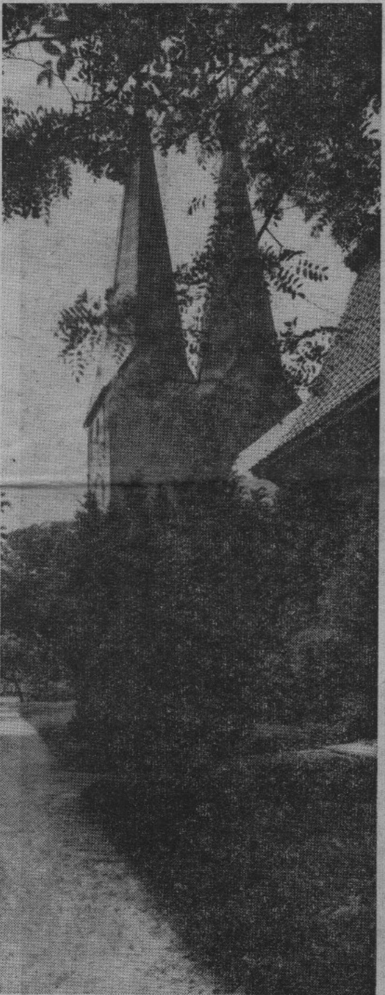
Die „beiden Schwestern“ der Nikolaikirche zu Altenbruch
