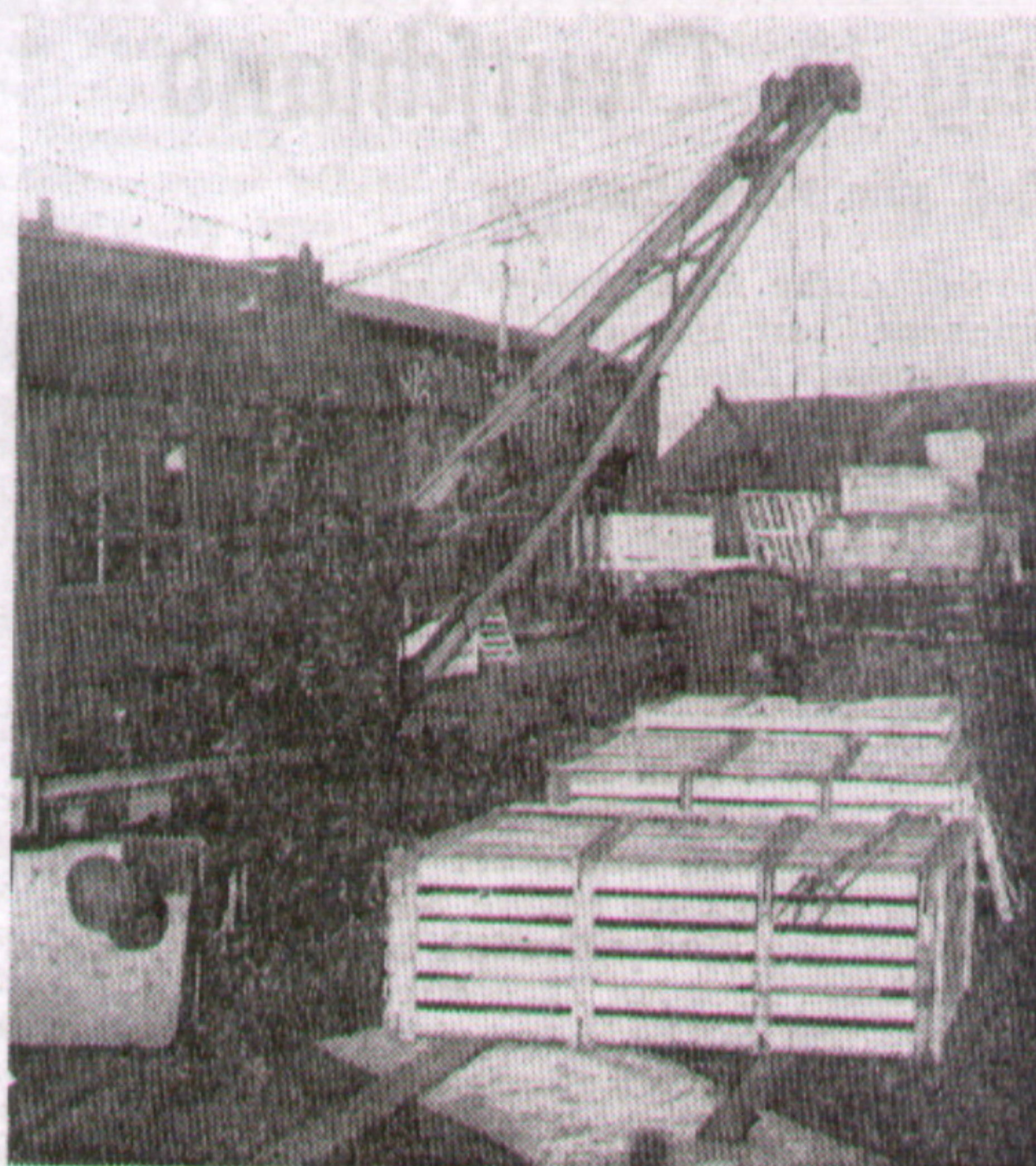
Bild oben: Probefahrt des kleinen Heckraddampfers „Congonixe“ auf der Lesum um 1907. Das einspalrige Bild zeigt in Kisten verpackte Einzelteile von Heckraddampfern der Frerichswerft fertig zum Transport nach Übersee
