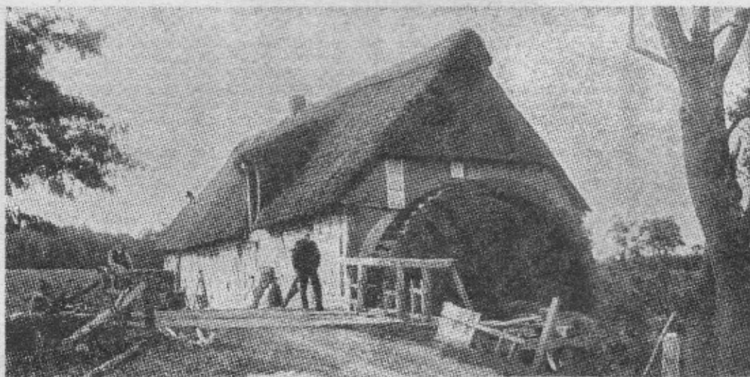
Wassermühle an der Gackau, 1925 abgebrochen
