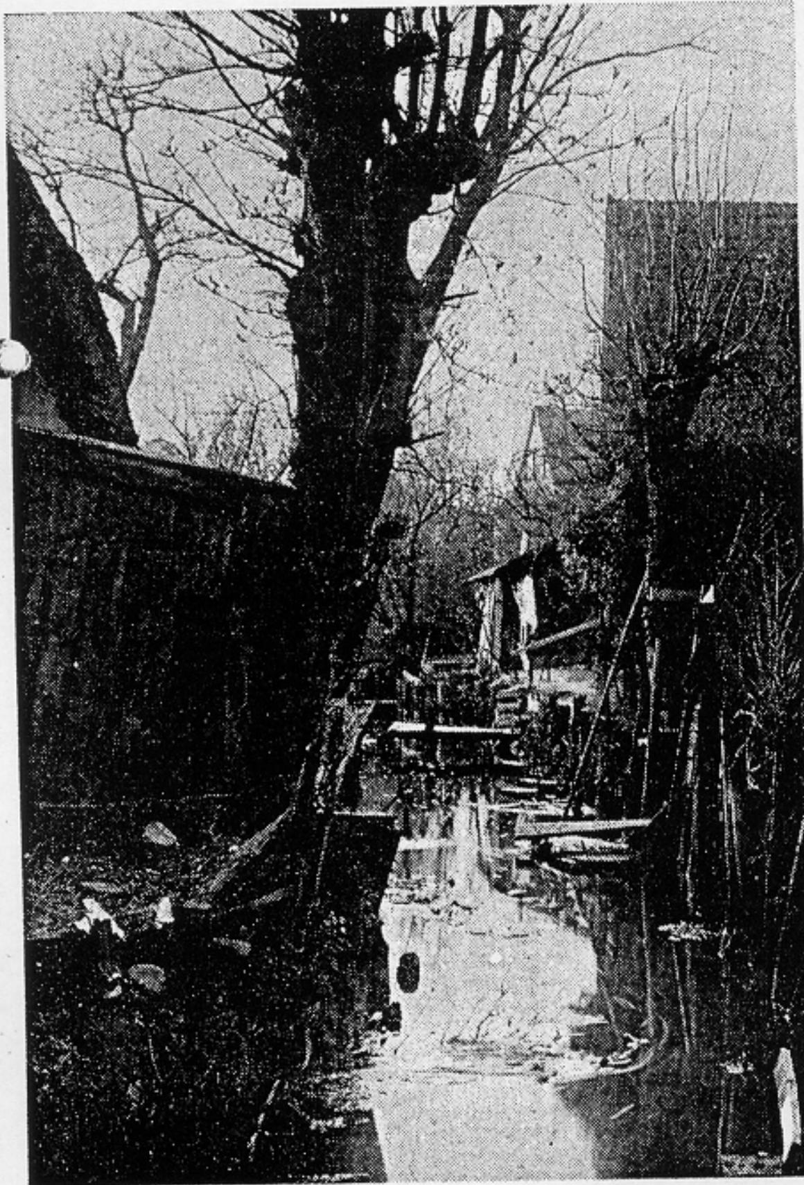
Wasserlösen sorgten für Entwässerung und Wasserversorgung
