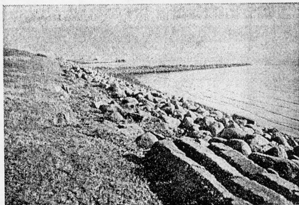
Erneuerung der Steinbuhne
