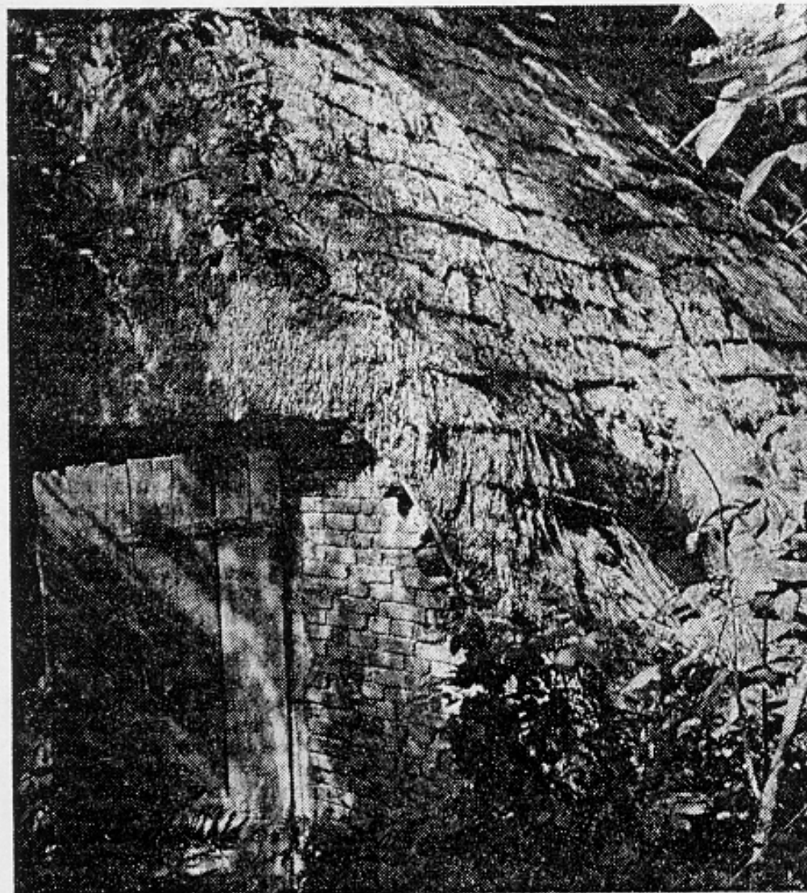
Dieses Foto der letzten Moorkate aus Hymendorf stammt aus dem Jahre 1950. Kurz danach wurde sie abgerissen.
