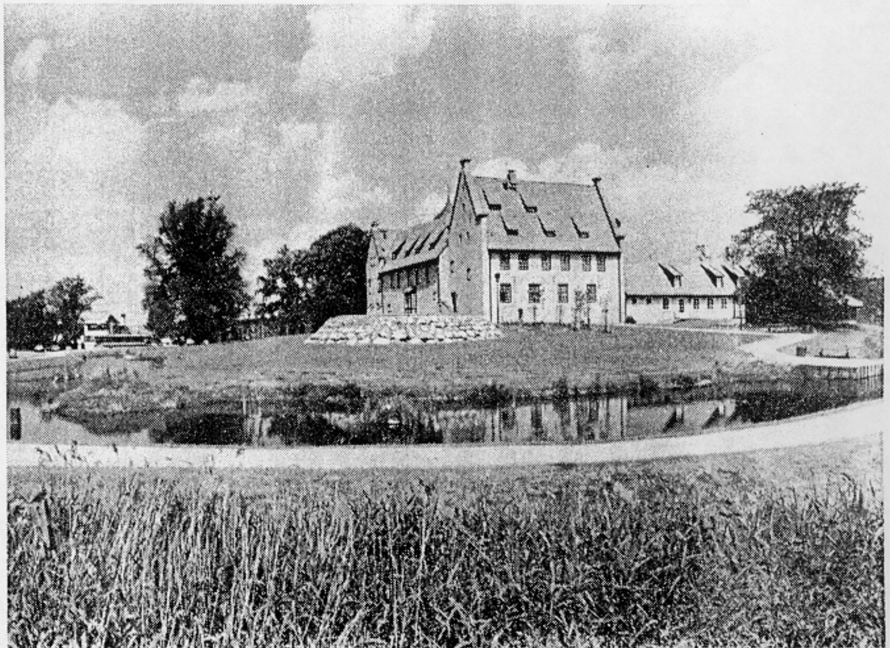
Burg Bederkesa im Juni 1983 mit Bastion und Graben von Südwesten
