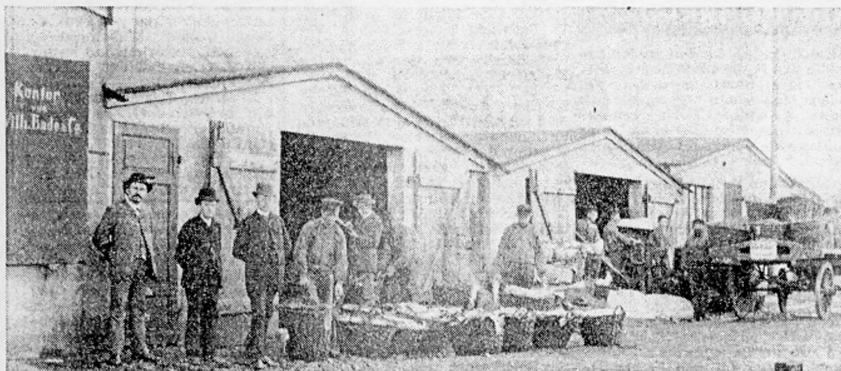
Fischhallen der Fa. Bade am Geesteufer (Morgenstern-Museum)
