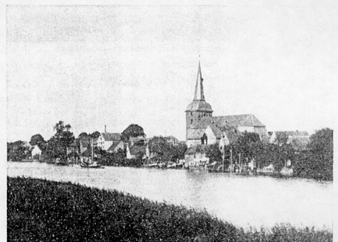
Eine historische Aufnahme von Osten kurz nach der Jahrhundertwende. Die Schwebefähre steht noch nicht.
