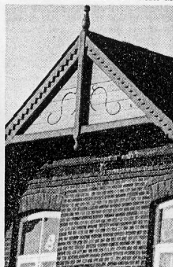
Raum zwischen Leersparren und Pfette verbrettert (Ihlienworth).
