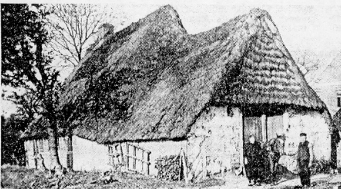
„Handkathe“ des Schäfers Nadolski nach 1910. Von dem Flechtwerk der Vorderfront ist der Lehmbewurf teilweise abgefallen.
