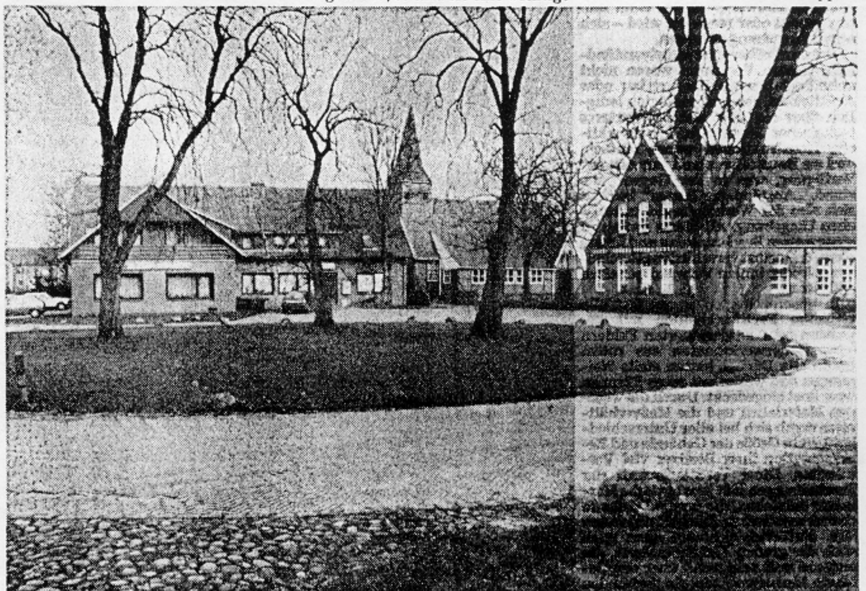
Der im Rahmen der Flurbereinigung hergestellte Platz in der Ortsmitte von Altlluneberg, ein Beispiel einer guten Platzgestaltung.
