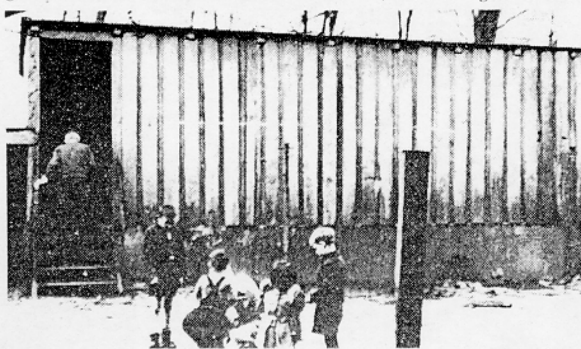
Die Latrine der Wohnanlage auf der Rickmers-Werft, ca. 1930.
