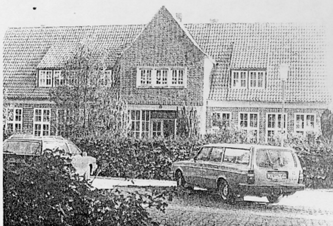
Die Schule. 1952 erbaut und mit zwei Klassen der Grundschule Ringstedt-Kührstedt noch in Betrieb.
