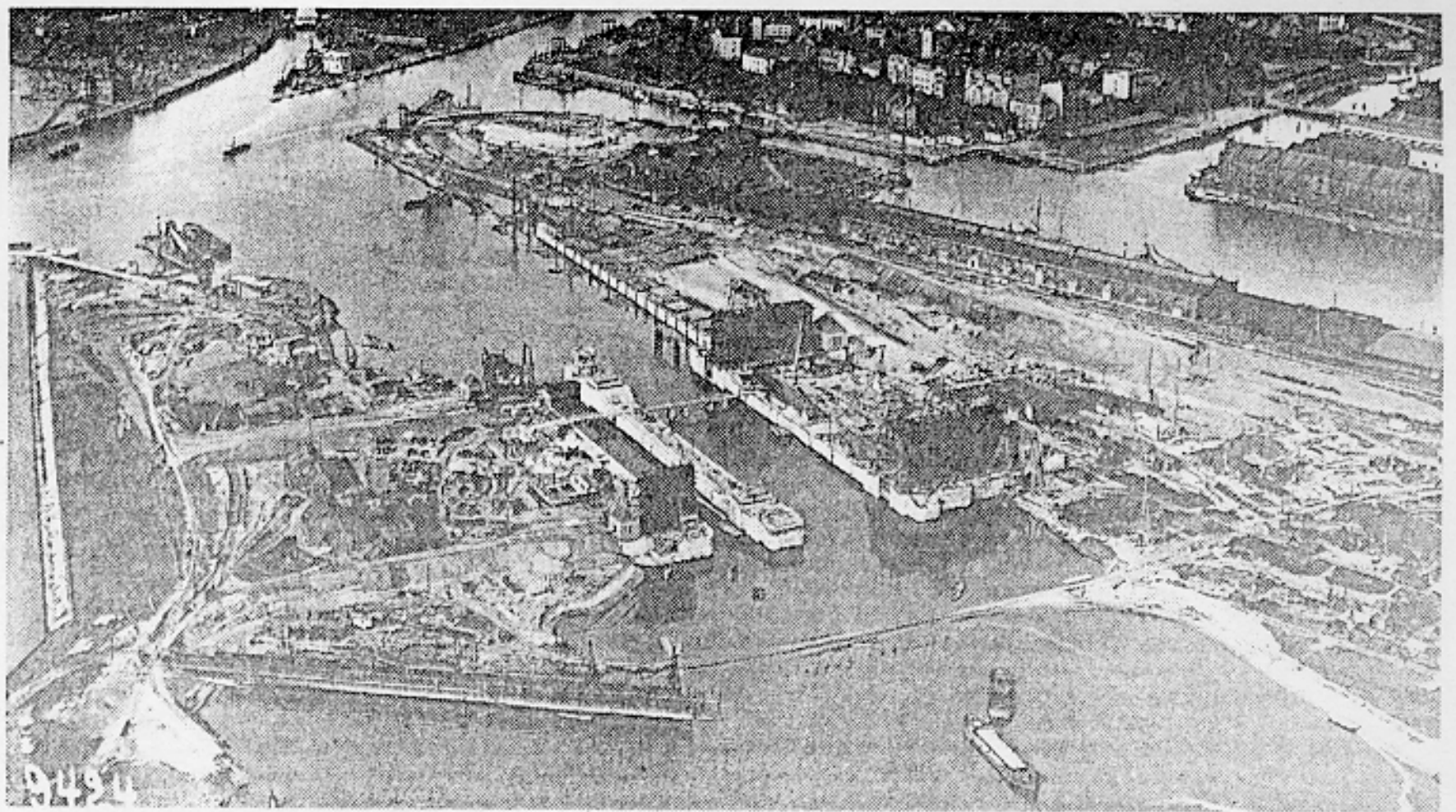
Luftaufnahme vom Bau der Fischereihafen-Doppelschleuse, 1924.
