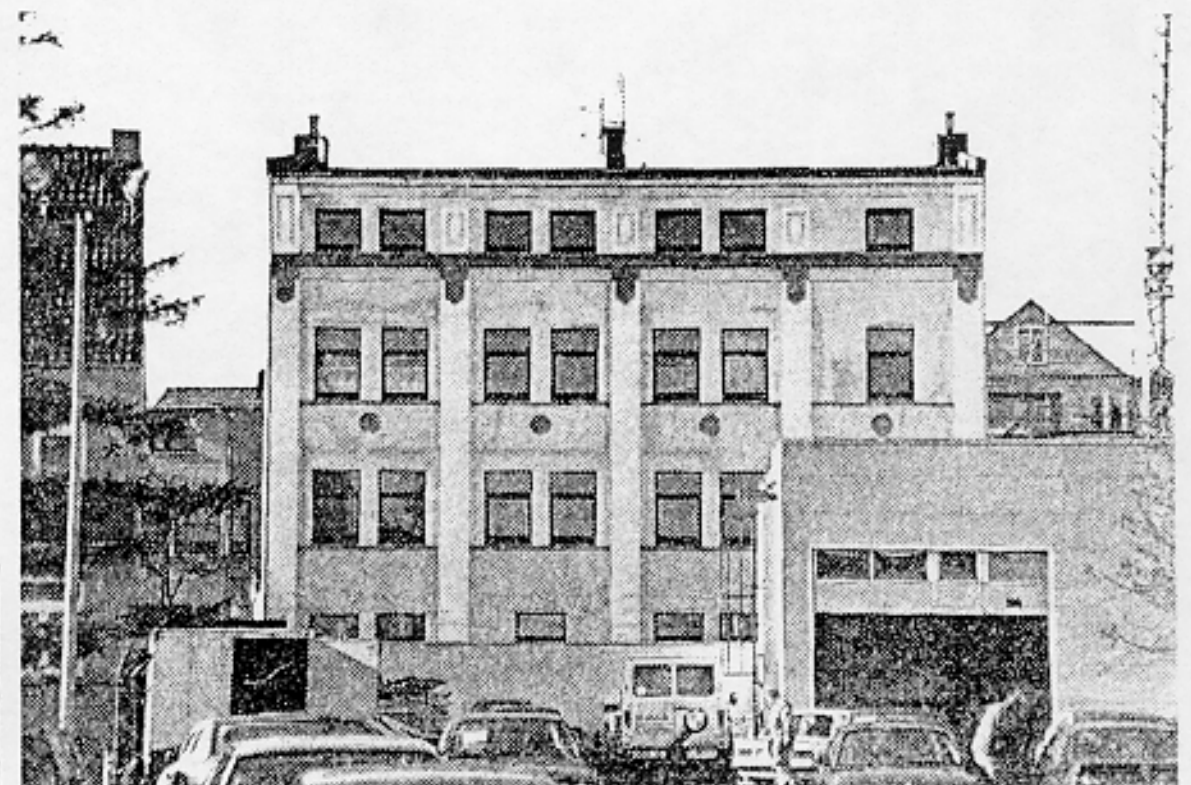
Die ehemalige „Bonschenfabrik“ von der Pieperstraße aus gesehen.
