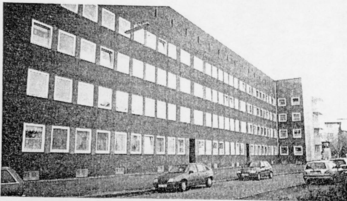
Blick von der Straße „Am Twischkamp“ auf das Gebäude.
