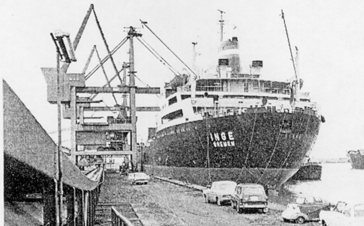
(Foto: Klöckner-Werke) Erzlagerplatz 1 mit Platzentlade- und -beladebrücke
