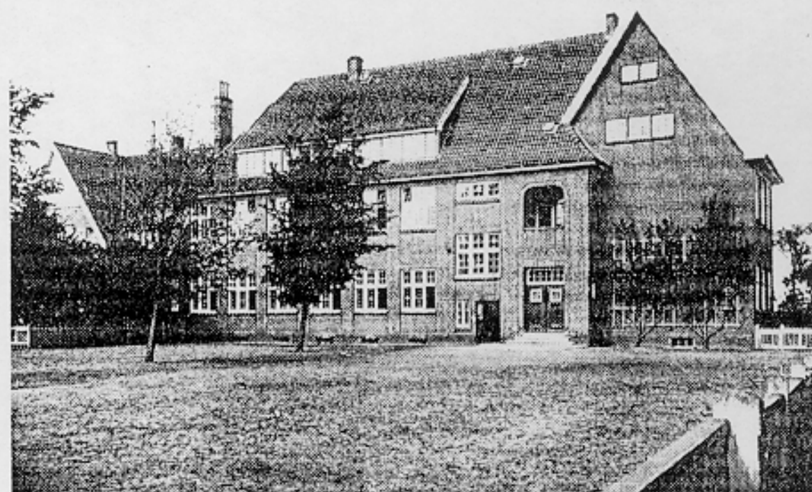
Grodenener Schule, Einweihung 1912, Architekt: Achmet Steinmetz.
