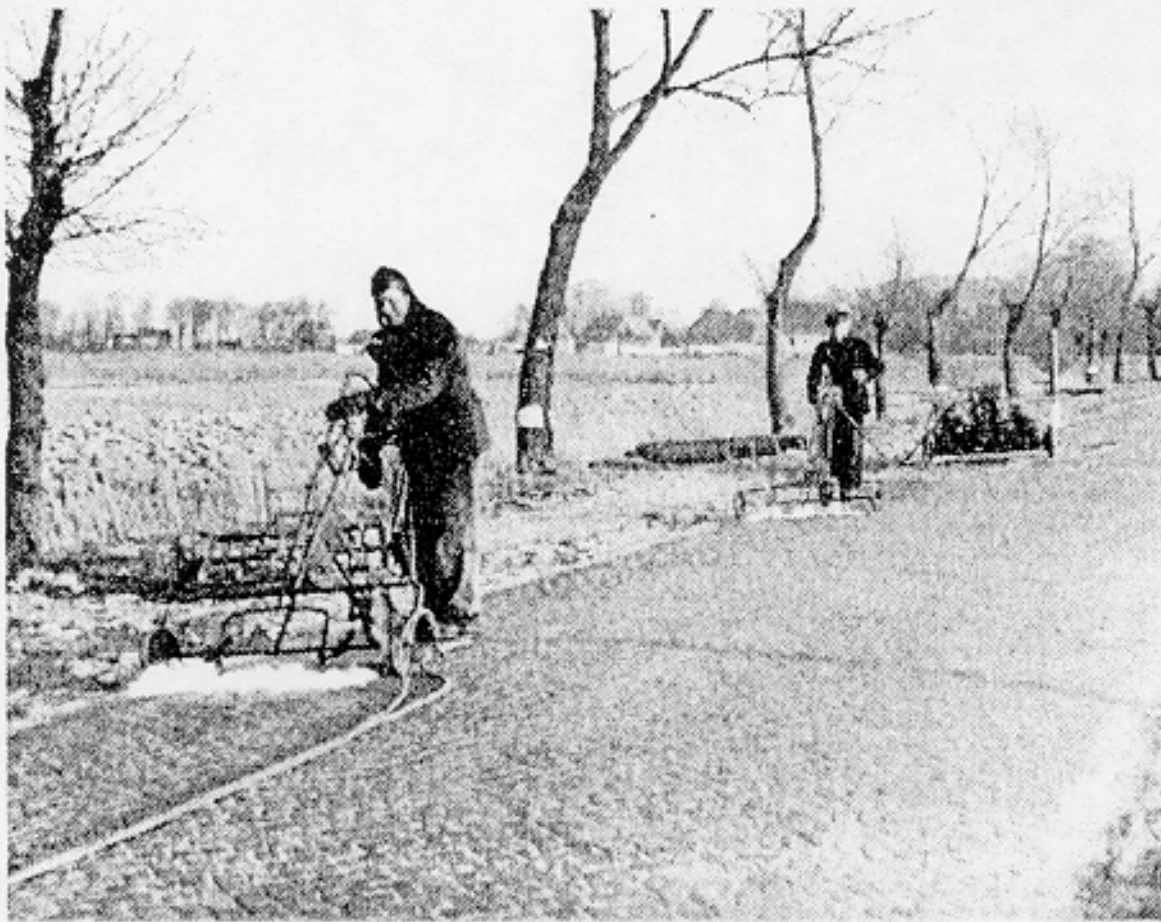
Mit diesen Geräten, im Volksmund Flammenwerfer genannt, wollte man Mitte der fünfziger Jahre das Basaltpflaster aufräumen. Damit sollte auf den Fahrbahnen die Glätte „entschärft“ werden.
