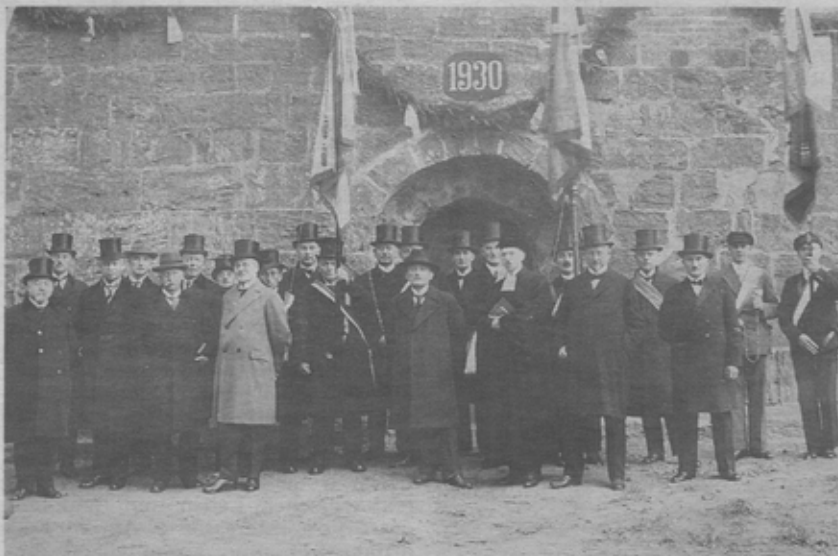
Die Richtfestfeier mit Gästen und Handwerkern vor dem Turmeingang. In der Mitte (im Talar) Pastor Johann Möller, der von 1925 bis 1952 eine 1500 Seiten starke Chronik über Wremen schrieb. (Foto: Wremer Chronik)
