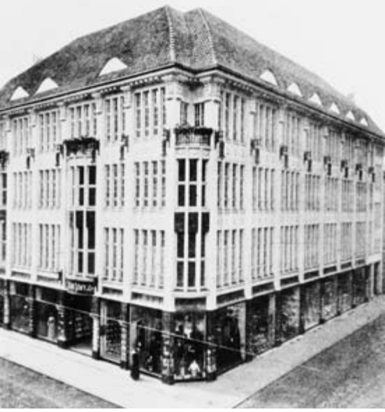
Das Kaufhaus Lewy nach dem Umbau von 1911
