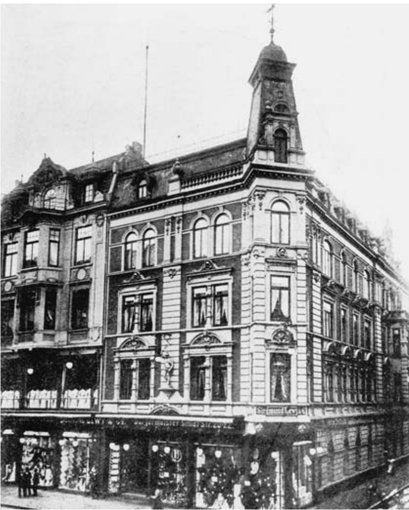
Das Kaufhaus Lewy als Wohn- und Geschäftshaus nach der Erweiterung von 1902
