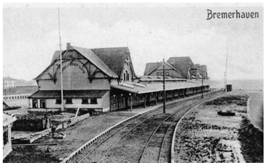
Lloydhalle (1899) mit zwei Gleisen an der Seeseite
