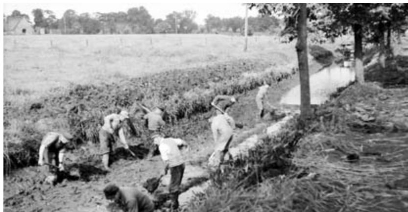
Kolonnenarbeit. Vertiefung der Wremer Wasserlöse vor mehr als 50 Jahren.
