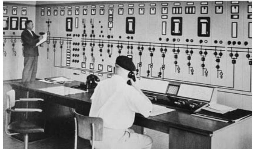
Netzleitstelle in Bremervörde. Vor über fünfzig Jahren eine der modernsten Anlagen dieser Art (Foto aus „Strom zwischen den Strömen“).
