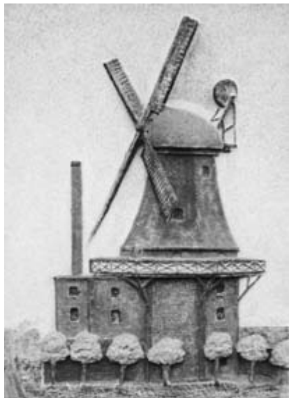
Die frühere Windmühle Brandt in Wremen als Relief. Links erkennt man den Schornstein von der Dampfmaschine am Anbau der Windmühle. In diesem Anbau wurde der elektrische Strom erzeugt.
