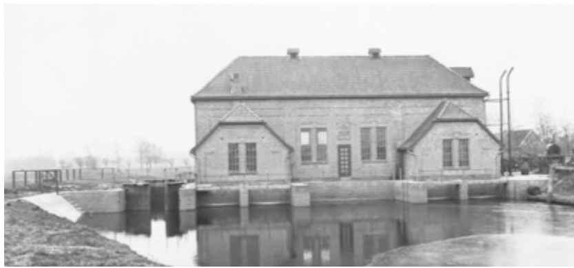
Das Ihlienworther Schöpfwerk kurz nach seiner Fertigstellung
