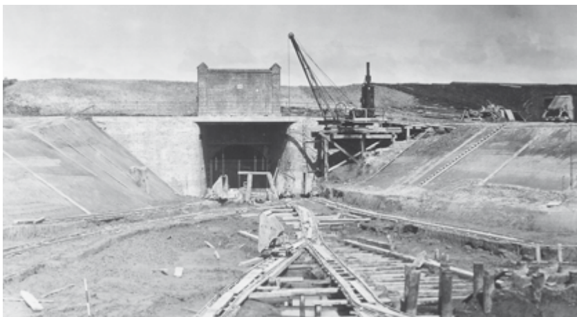
Deich- und Schleusenarbeiten in Otterndorf 1929
