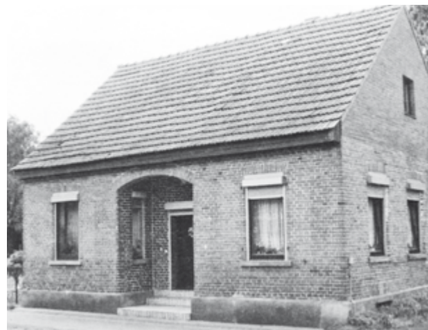
Dieses an der heutigen L135 in Dorfhagen gelegene Haus wurde 1845 als Chausseegeldnehmer-Haus errichtet.
