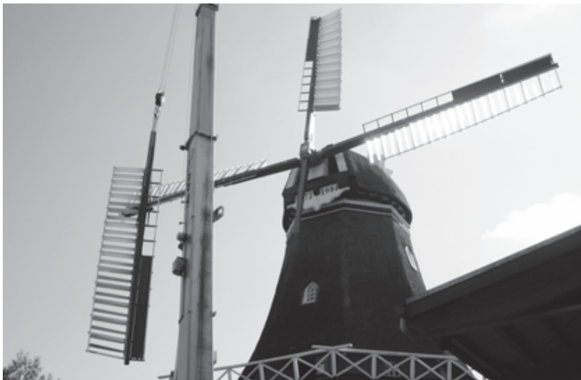
Mit dem Autokran wird heute die Flügelspitze zu Boden gebracht.
