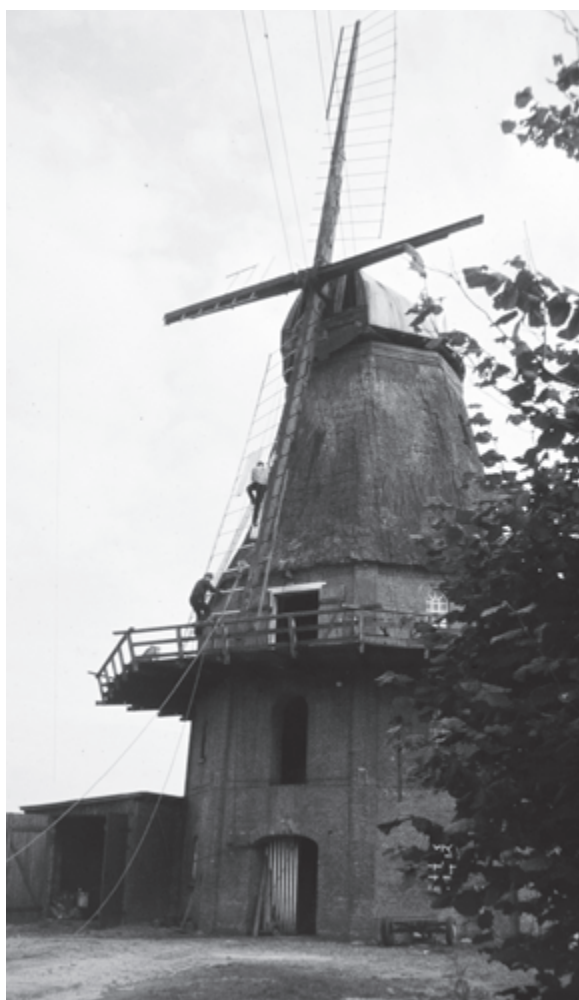
Gesamtansicht der Lintiger Mühle
