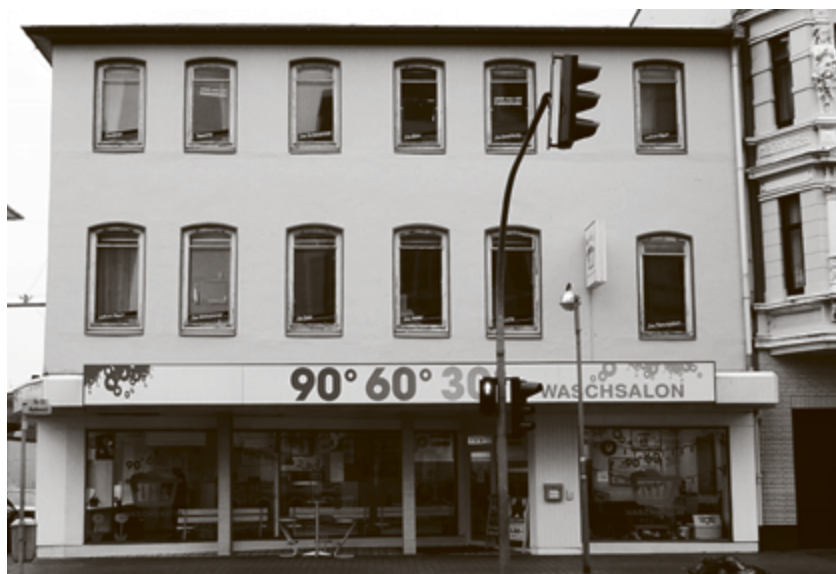
Das Haus Hafenstr. 76 im heutigen Zustand, 2011 (Foto: Verfasser)
