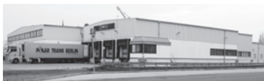
Zentralreiferei der Firma UNIVEG in der Steubenstraße an der Westseite des Verbindungshafens.
