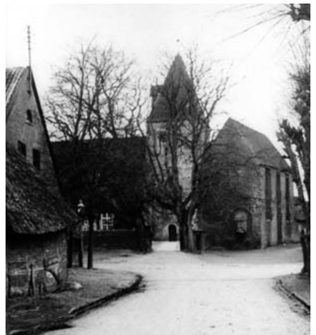
Die Wulsdorfer Kirche um 1920, Aufnahme von der Bremer Straße
