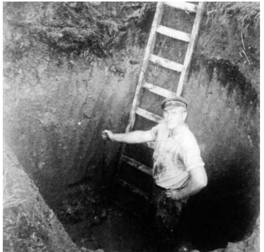
Bis zu 2,50 m Tiefe wurden die Kühlen gegraben
