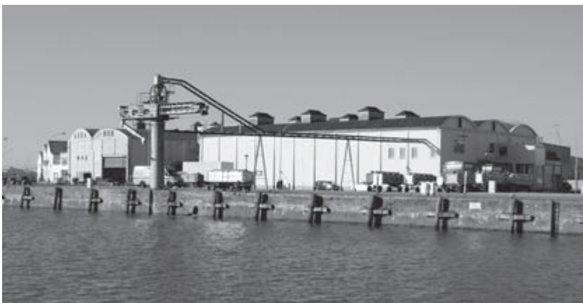
Bremerhavener Eiswerk GmbH 2012
