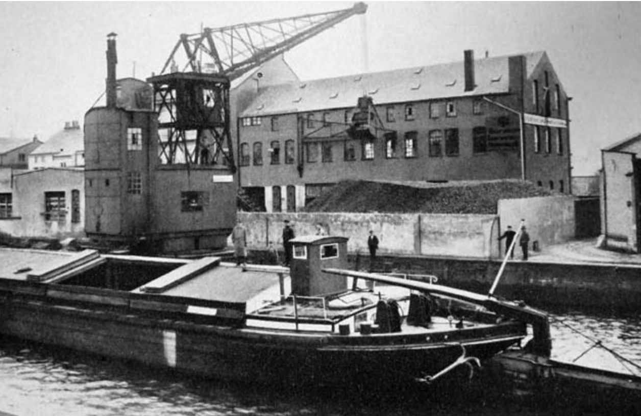
Ehemalige Anlagen der Fa. tom Möhlen & Seebeck, vom Querkanal aus gesehen, 1927, hier in der Nutzung durch den Konsumverein Unterweser (25 Jahre Konsum- und Sparverein „Unterweser“).
