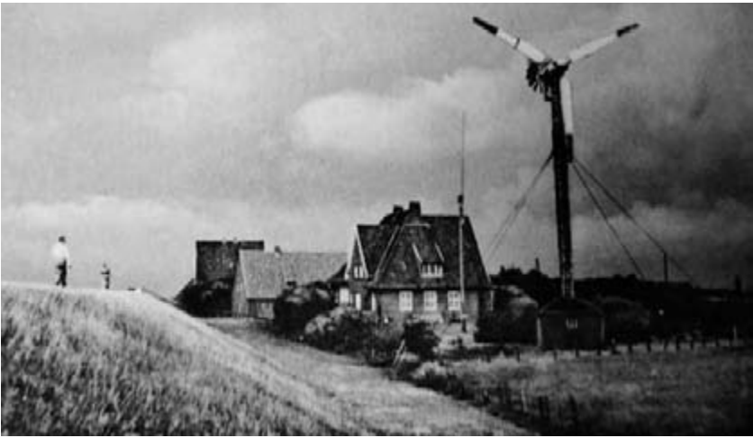
Windkraftanlage unmittelbar neben der Inselschule (Foto: Sammlung Eisermann).
